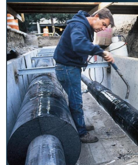
As seções StrataFab® foram instaladas em sequência, juntadas ponta a ponta (com a colocação de cintas PITTWRAP® nas interfaces) e seladas a quente.
