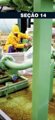
**FIGURA 11: Isolamento de Flanges na Linha**
