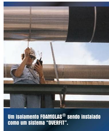
água nos sistemas de baixa temperatura é virtualmente eliminada e a eficiência térmica é mantida. Assim, o isolamento FOAMGLAS® não exige a colocação de barreiras de vapor (apesar de poderem ser usadas para obter proteção adicional).
